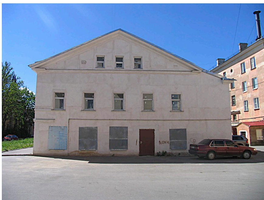
Рис. 5. Северный фасад дома № 21 с торцом пристройки (кузнецы). Современная фотография
