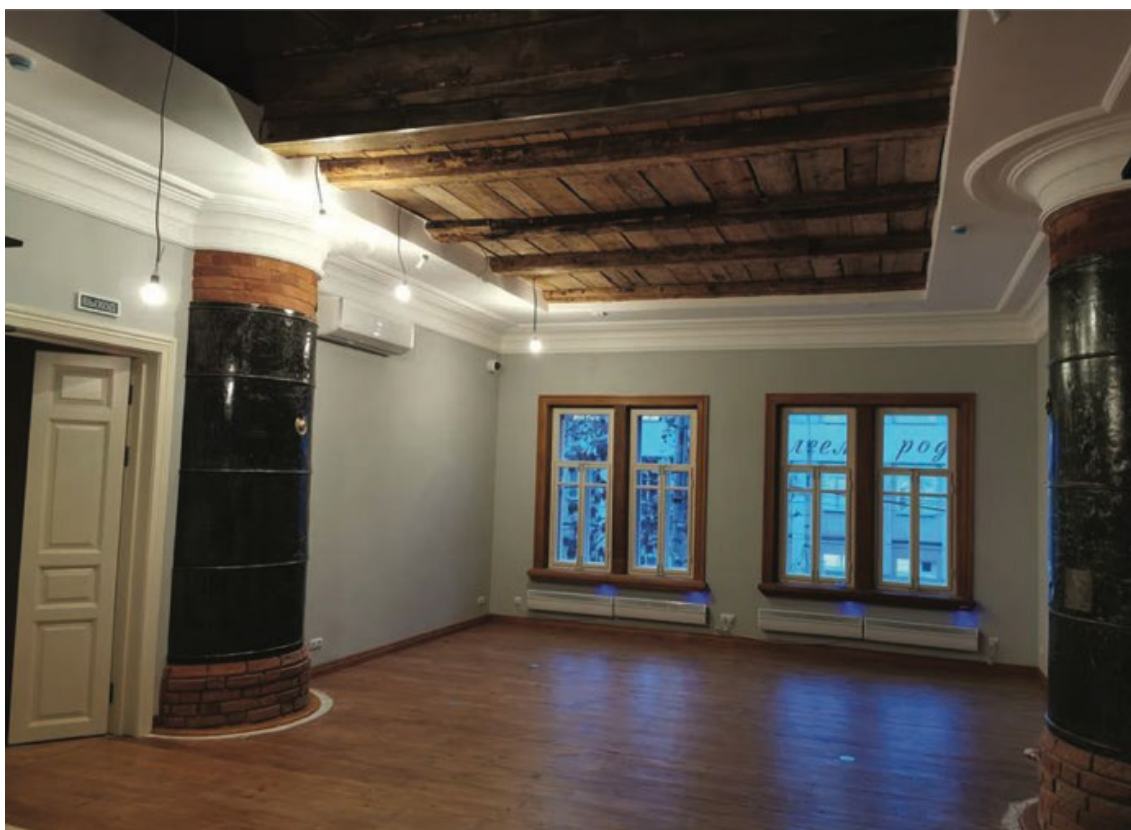
Рис. 9. Интерьер центральной комнаты на втором этаже с раскрытием исторических конструкций перекрытия после реставрации
