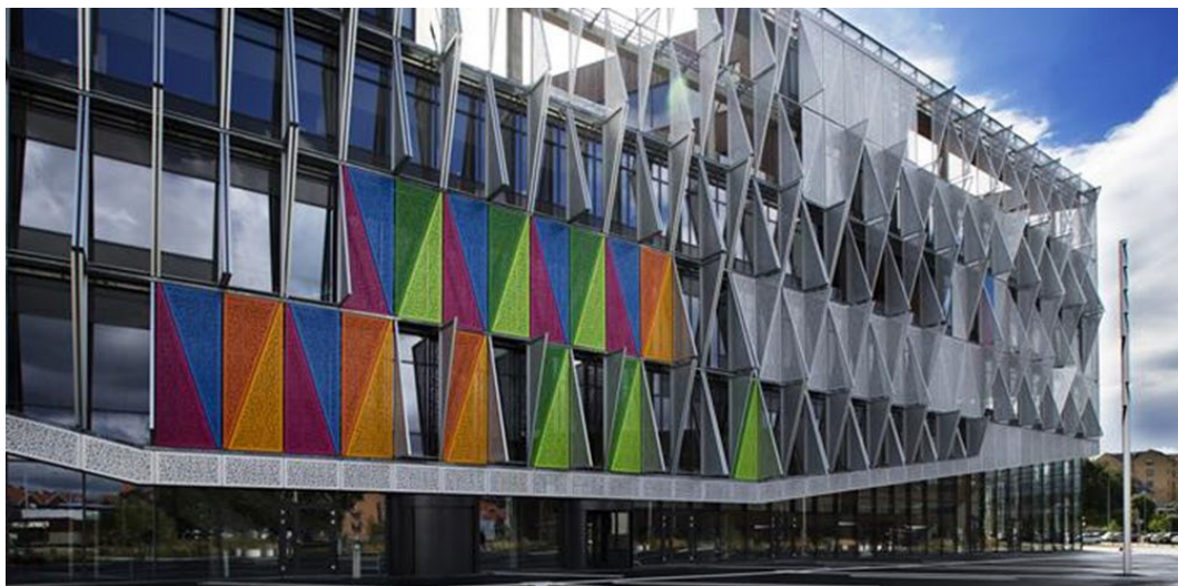
Рис. 3. Кинематика в архитектуре. Фасад здания кампуса университета в Кольдинге, Дания, 2014
