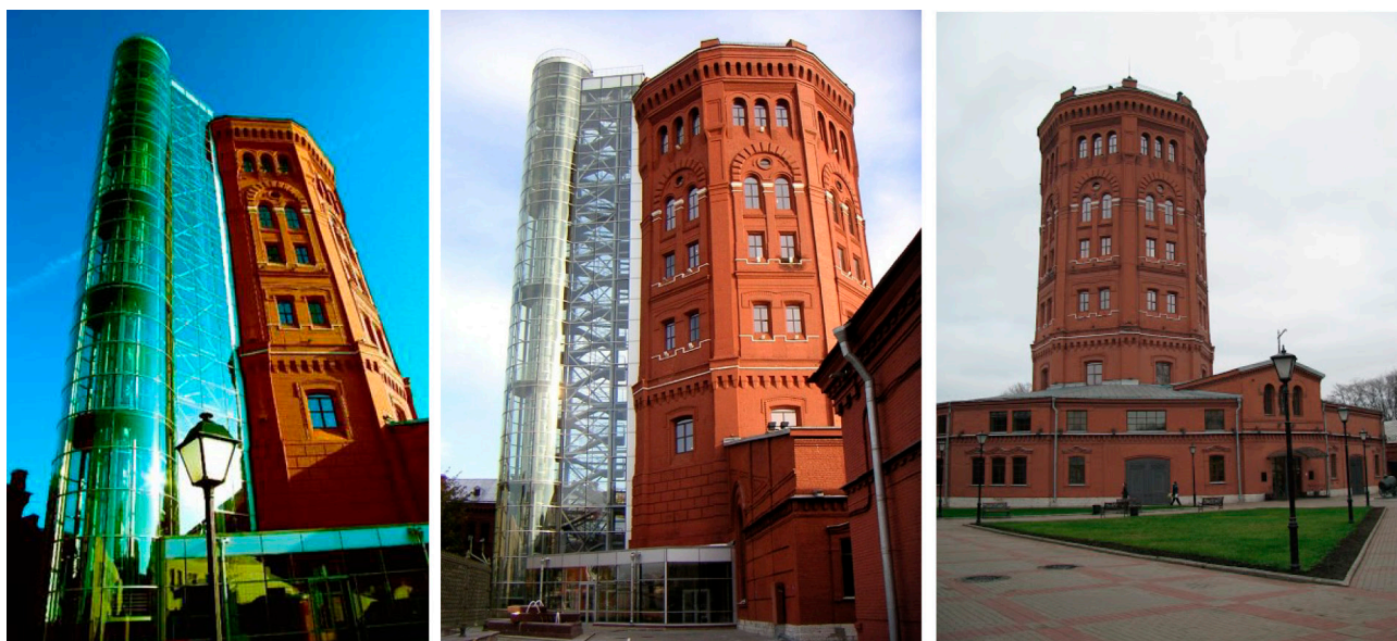
Рис. 4. Фотофиксация водонапорной башни, 2018 г.
