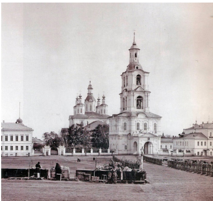
Рис. 5. Собор Троицы Живоначальной. Разрушен в 1931 году
